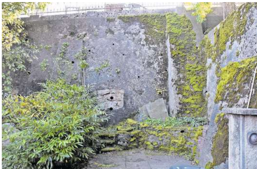
Die historische Stützmauer muss auf Sanierungsbedarf untersucht werden, ...
