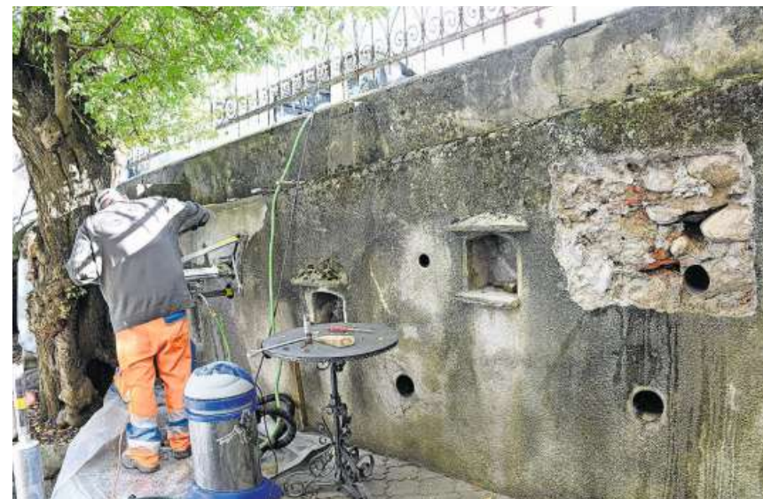
... dazu werden Gesteins- und Mörtelproben entfernt und überprüft.
